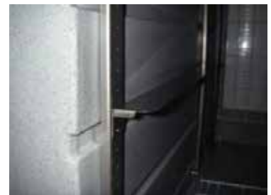
支柱&棚受け金具取付例
